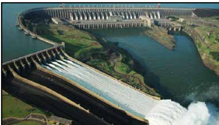
FIGURA 31 – USINA DE ITAIPU
