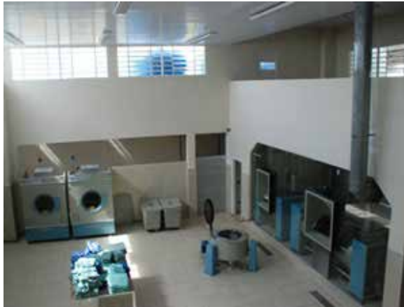
FIGURA 20 - FOTO ILUSTRATIVA DE UMA LAVANDERIA HOSPITALAR
